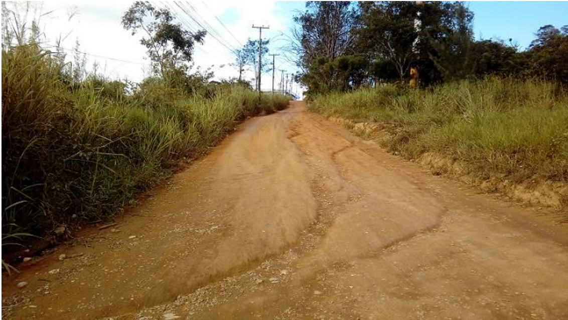
Figura – 9 Rua ao lado do Empreendimento Estrada Bela Vista.
