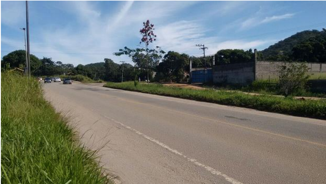
Figura 7 - Rodovia Amaral Peixoto RJ 106 em frente ao Empreendimento
